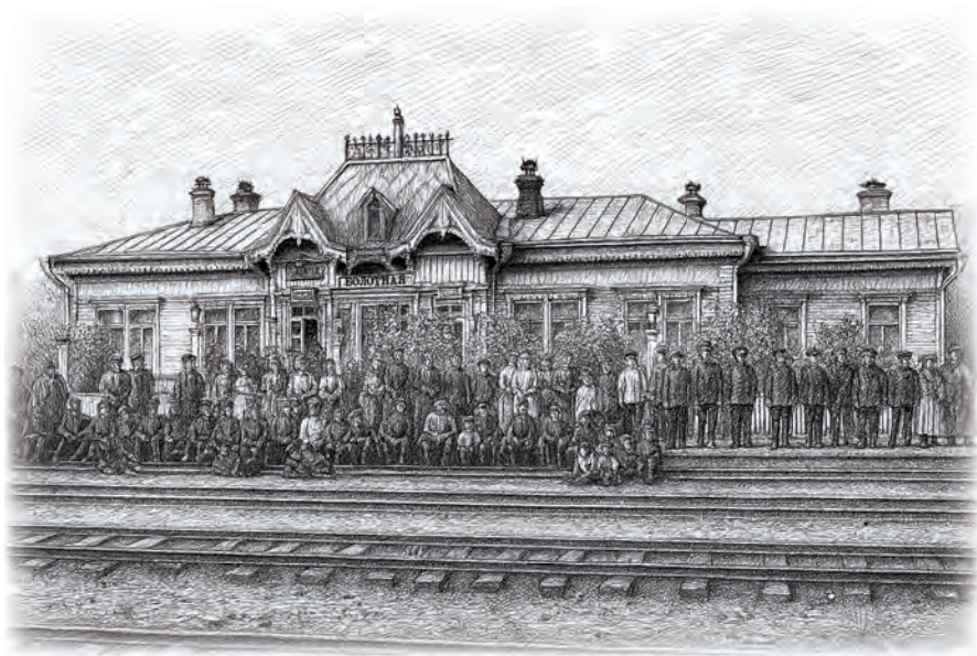
Вокзал станции Болотная
